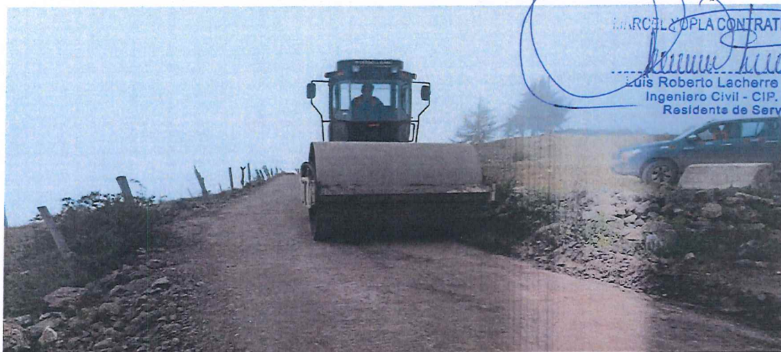
FOTOGRAFIA N°13: Corroboración de niveles pendientes y peraltes en la carpeta.
