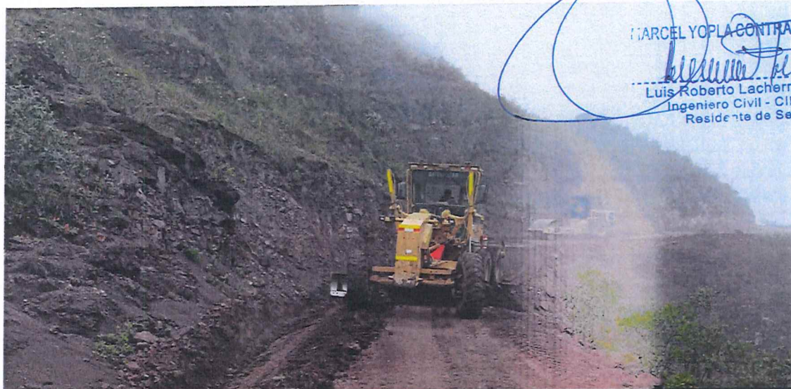
FOTOGRAFIA N°11: descarga de material granular afirmado.
