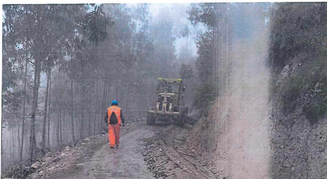
FOTOGRAFIA N°15: señalización en zona de trabajo.
