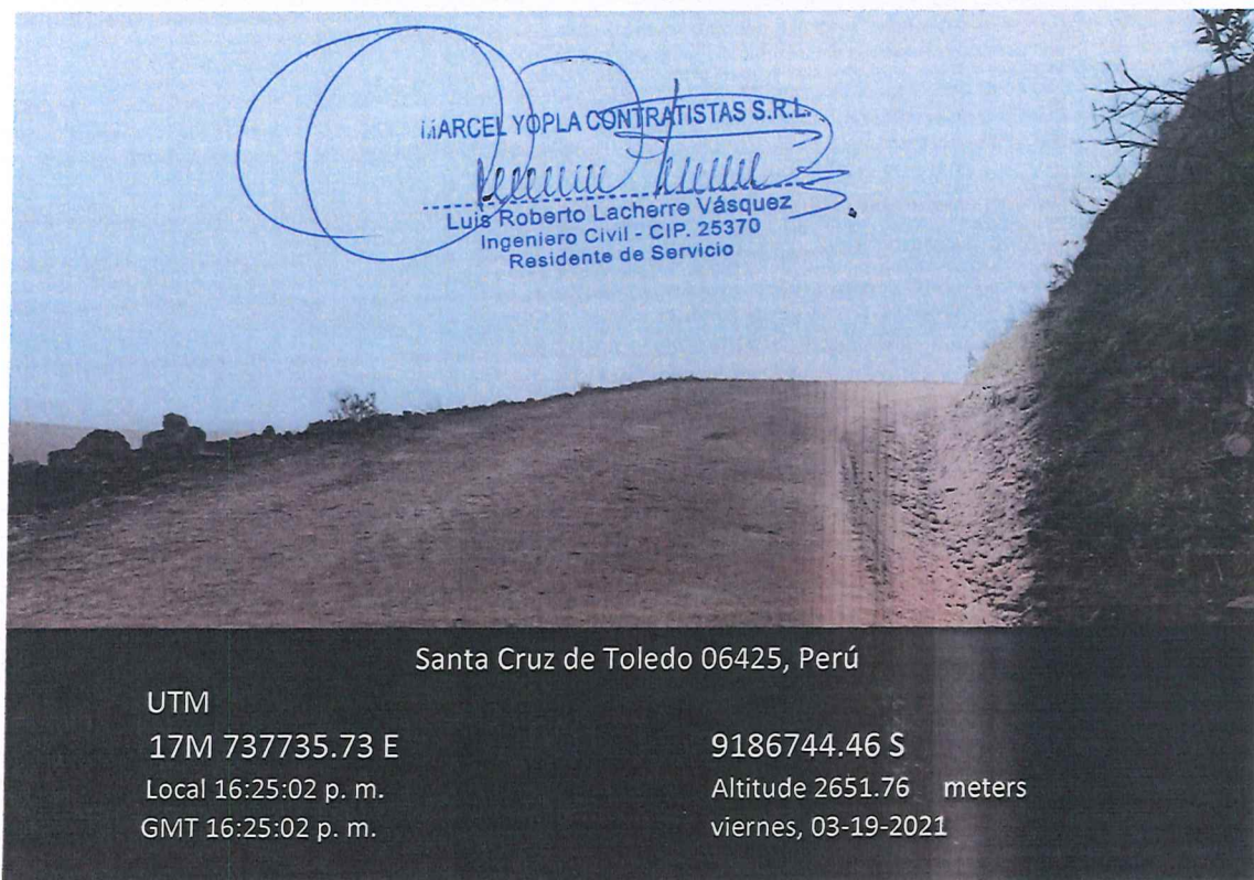
FOTOGRAFIA N°18: culminación de compactación en la superficie de rodadura.
