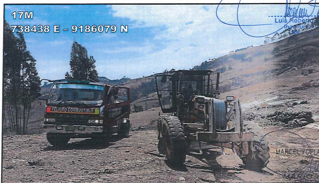
FOTOGRAFIA N°02: Cisterna para combustible y motoniveladora en patio de máquinas.
