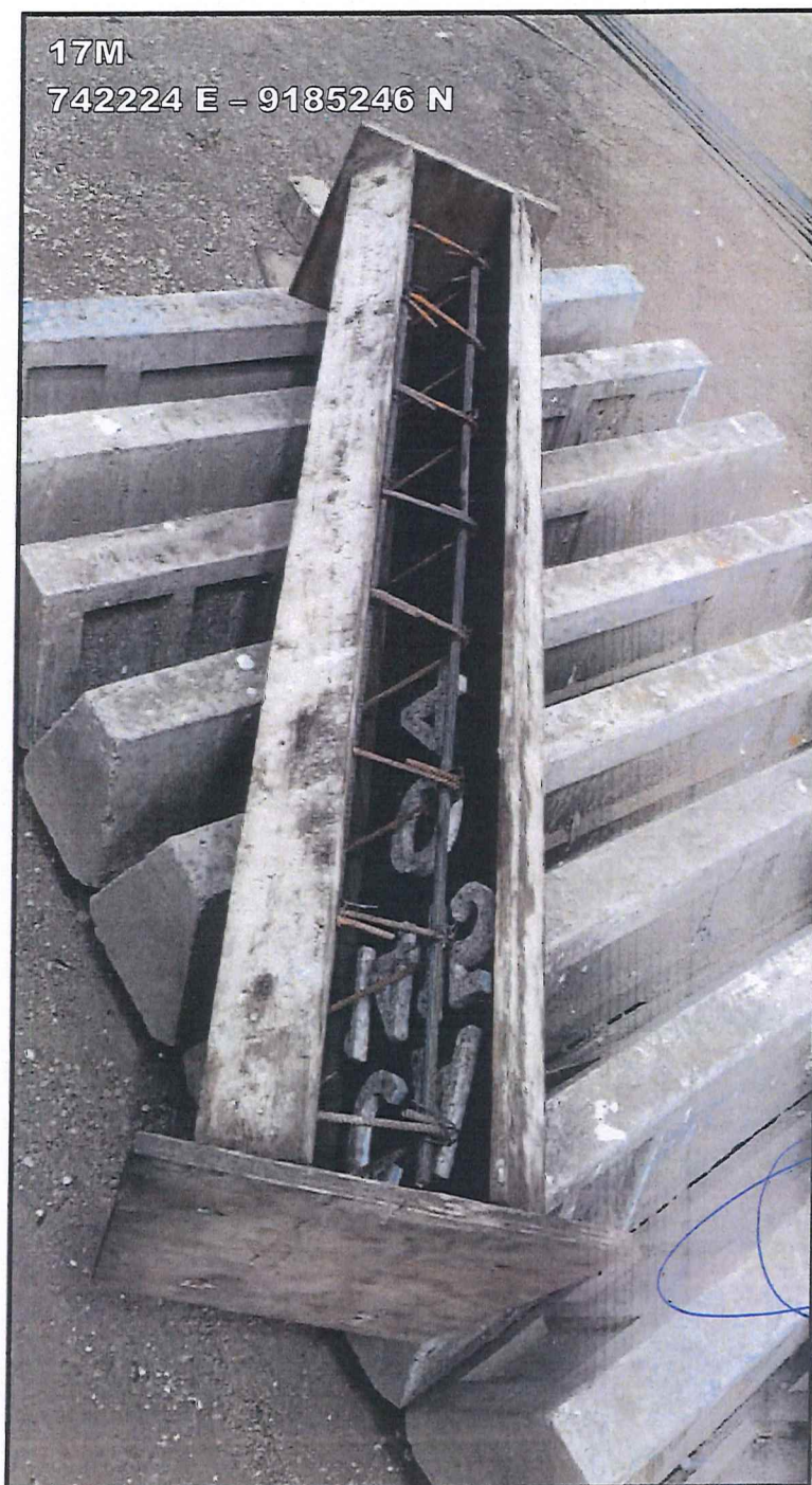
FOTOGRAFIA N°07: Construcción de hitos kilometricos
